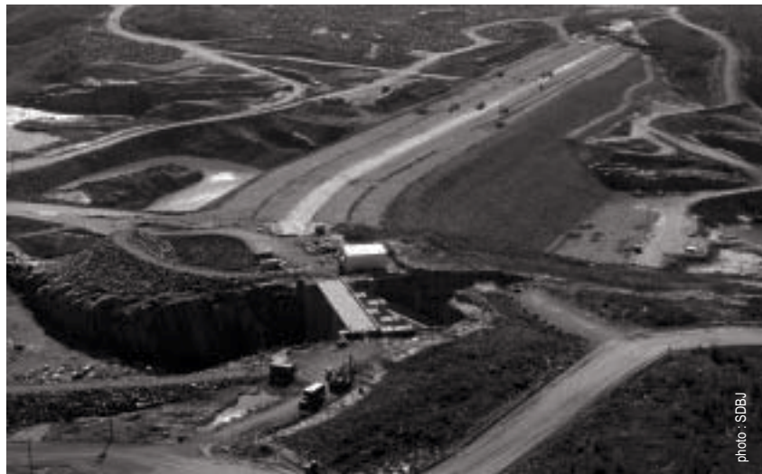
Le site du barrage et de l'évacuateur de crues de l'Eastmain-1
